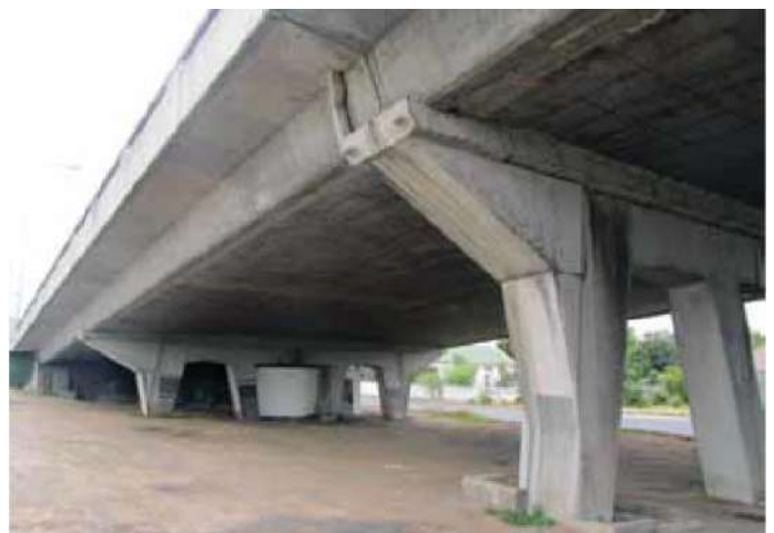
Foto 1: Intersección de Liesbeeck Parkway mirando hacia Table Mountain mostrando las ménsulas de acero recubiertas mediante sistema Dúplex. Fotos 2 - 3: Las ménsulas de acero recubiertas mediante sistema Dúplex, aunque se ven ligeramente decoloradas por agua de lluvia, permanecen intactas.
