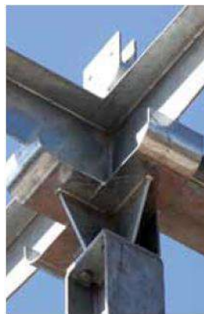
Foto 3: Vista del cabezal elaborado pero esencial de la columna de acero. Foto 4: La estructura galvanizada por inmersión en caliente define claramente los extremos de la plataforma del piso de madera y los componentes del acristalamiento.
