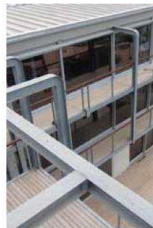
Foto 3: Vista del cabezal elaborado pero esencial de la columna de acero. Foto 4: La estructura galvanizada por inmersión en caliente define claramente los extremos de la plataforma del piso de madera y los componentes del acristalamiento.
