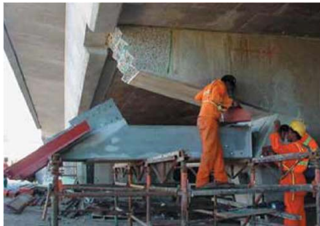
Foto 4: Anclaje positivo de los elementos de ensanche de los pilares a la estructura existente mediante el uso de anclajes postensados GEWI. Foto 5: Preparación del pilar de hormigón armado existente para acomodar la ménsula y el puntal de acero estructural galvanizado por inmersión en caliente.
