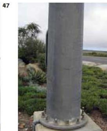
Fotos 47-48: Los mástiles perimetrales de Petro SA cerca de Mossel Bay que se instalaron desde el inicio de la planta (25 años). Fotos 49-50: Espesor del revestimiento en la tuerca de sujeción (211 µm) y en el mástil (159 µm) respectivamente.
