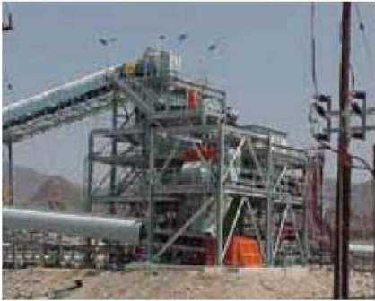
Fotos 16-19: Vistas de la Fundición de Platino Marula y el acero estructural galvanizado por inmersión en caliente, incluida la estructura del transportador desde un túnel inclinado hasta las diferentes plantas de procesamiento en la mina.
