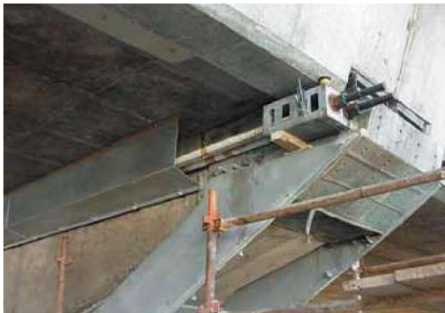
Foto 4: Anclaje positivo de los elementos de ensanche de los pilares a la estructura existente mediante el uso de anclajes postensados GEWI. Foto 5: Preparación del pilar de hormigón armado existente para acomodar la ménsula y el puntal de acero estructural galvanizado por inmersión en caliente.
