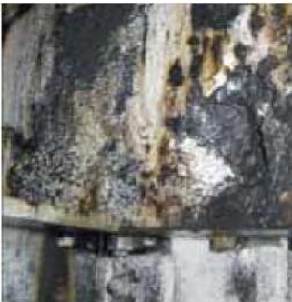
Fotos 20-21: La agresividad del medio ambiente en la planta de lavado de carbón Twistdraai Colliery. Fotos 22-23: El espesor total del revestimiento del sistema de un sistema Dúplex de 336 µm y 378 µm respectivamente.
