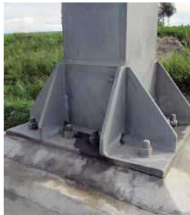
Foto 7: espesor de revestimiento de 634 µm en la placa base.
